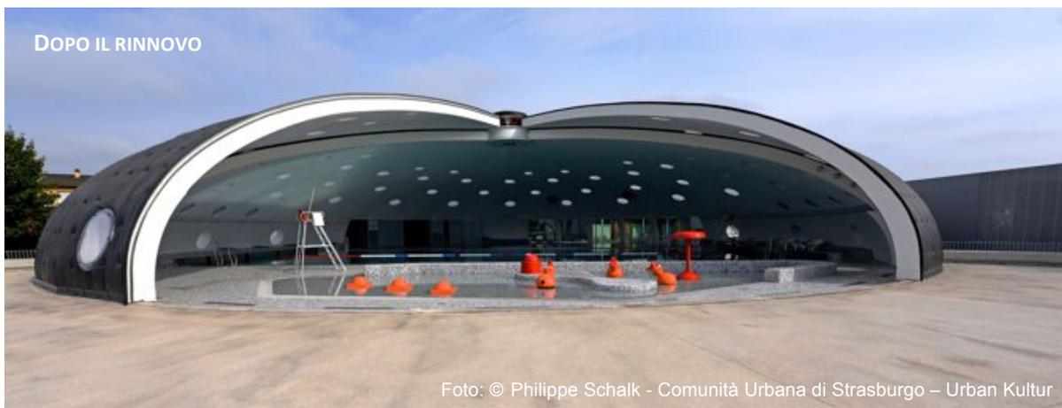
La forma dell'edificio principale, a cupola, ha reso l'operazione di ristrutturazione particolarmente complessa, ma lo studio è riuscito ugualmente a prevedere nel piano di rinnovo un radicale miglioramento termico dell'edificio e la ricostruzione degli involucri interni ed esterni.
